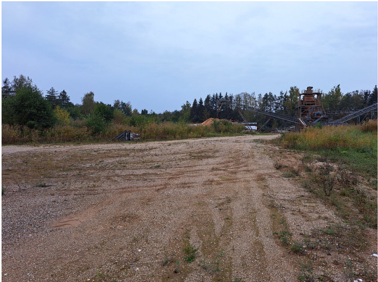
Abb.: geplante Anlagenfläche, Blick in Richtung Westen zu den Aufbereitungsanlagen für Sand und Kies
