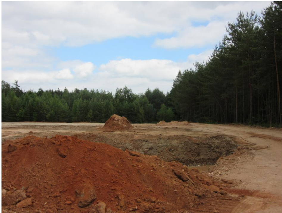
Foto 7: Restliche Rohstoffentnahme mit anschließender Verfüllung der Wasserlöcher im Südwesten des Grundstücks bei der Zufahrt für die Parzelle; 14.06.
